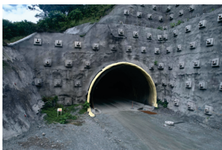
Portal entrada túnel 1
