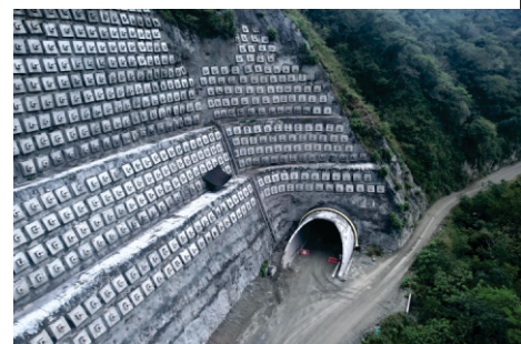
Portal salida túnel 2
