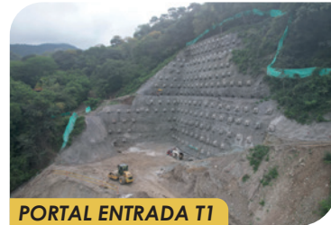
PORTAL ENTRADA T1
