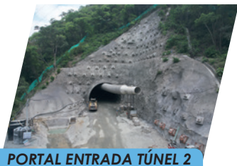
PORTAL ENTRADA TÚNEL 2
